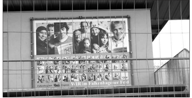
Klubhausbaustelle mit Plakat
