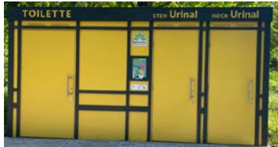
Testphase für die neuen Toiletten
