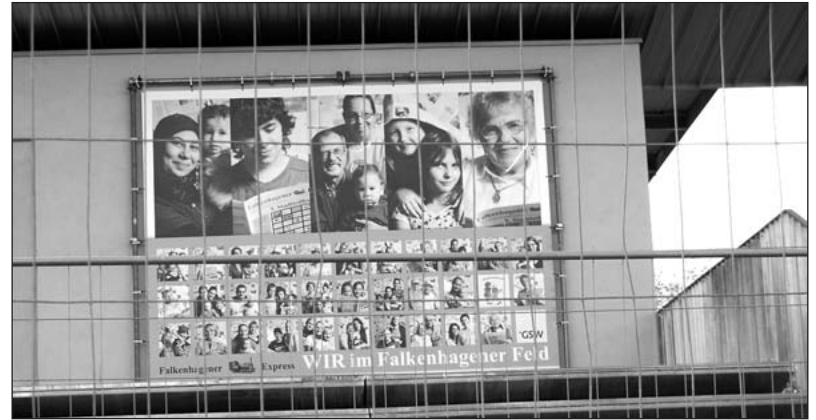
Klubhausbaustelle mit Plakat
